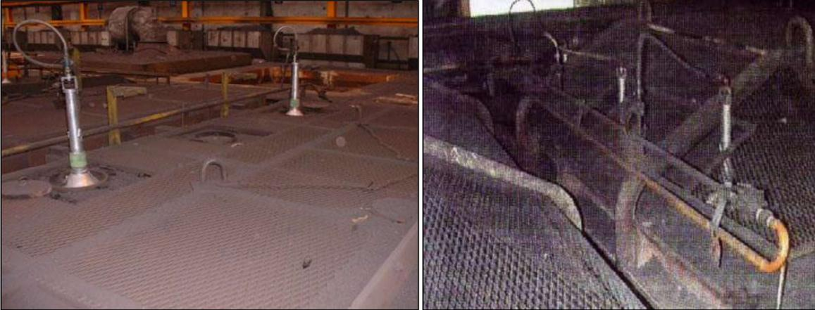
**Figure 4 : Rampe d'alimentation gaz et brûleurs sur le tampon d'une chambre**
