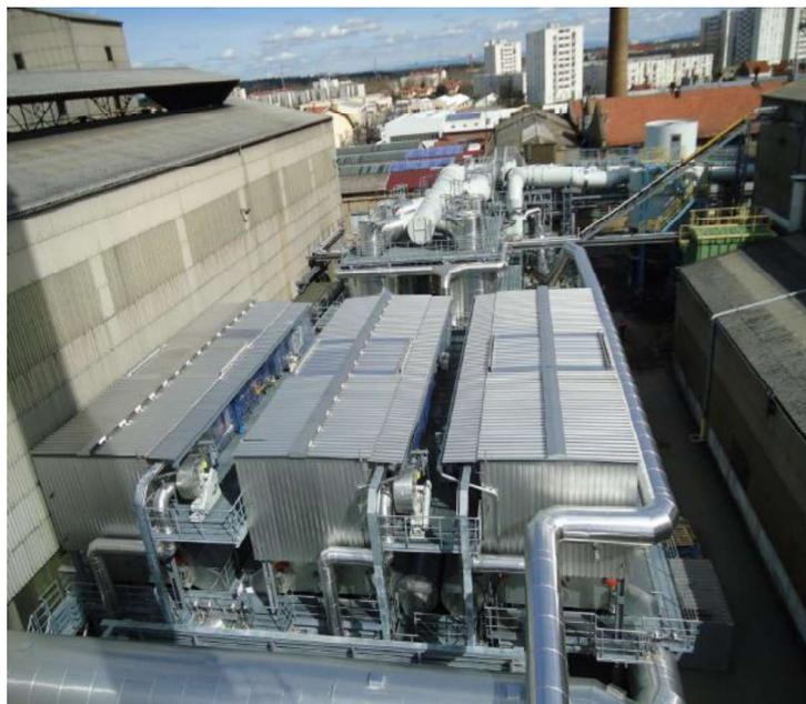
**Figure 5 : Visualisation du système d'oxydation thermique régénératrice (OTR)**
